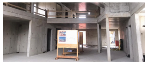
Rohbau: Physikbereich (unten) und Chemiebereich (oben)
