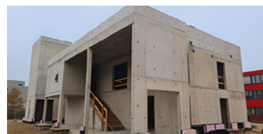
Rohbau des Jugendforscher*zentrums
